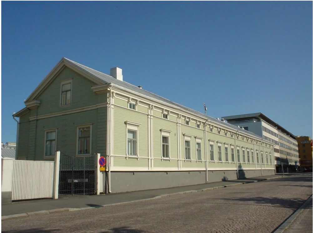
Kuva 1: Albertinkadun ja Kirkkokadun kulmassa sijaitseva Snellmantalo. Rakennuksessa sijaitsee nykyään Svenska Privatskolan sekä Svenska Barnträdgården (Kuva Marja Väyrynen)
